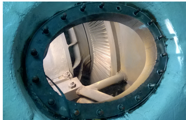
FIGURE 8.14 – Hublot d'inspection d'une des turbines basse pression (puissance \sim 25 \text{ MW} ) du porte-avions USS Hornet lancé en 1943.
