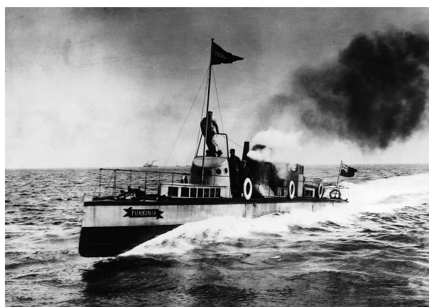
FIGURE 9.23 – Le Turbinia , yacht de Charles Parsons servant de démonstrateur pour ses recherches en propulsion maritime. Avec ses trois turbines à vapeur et ses neuf hélices, il atteint 60 km/h et permet à son propriétaire de ridiculiser la Royal Navy pendant le défilé du Jubilee de la reine Victoria en 1897.
