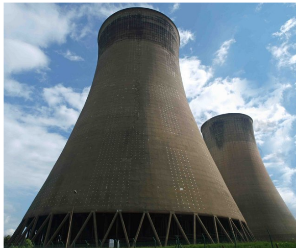
FIGURE 9.9 – Cheminées de refroidissement de la centrale à charbon de Eggborough (1967, 1 960 MW) au Royaume-Uni. Dans ces cheminées, la chaleur prélevée à l'eau du circuit dans le condenseur est évacuée dans l'atmosphère. Ce refroidissement est effectué au moyen d'un circuit d'eau secondaire, qui est mis en contact avec l'atmosphère et s'y évapore partiellement.
