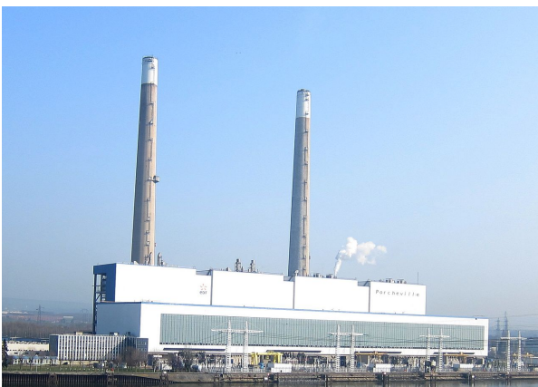
FIGURE 9.27 – Centrale électrique de Porcheville, alimentée au charbon jusqu'en 1987 et fonctionnant désormais au fioul. Elle sert principalement les demandes de pointe.
